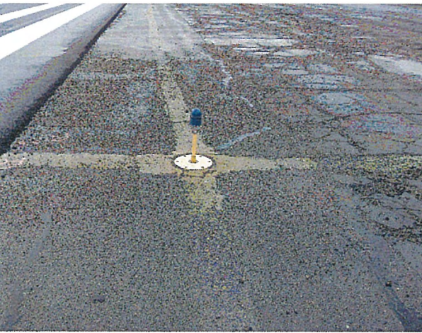
3 EXISTING EDGE LIGHT PCC D12 SCALE: NTS
